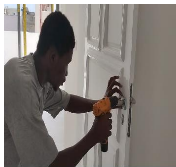
Photo g : Vissage de poignets
